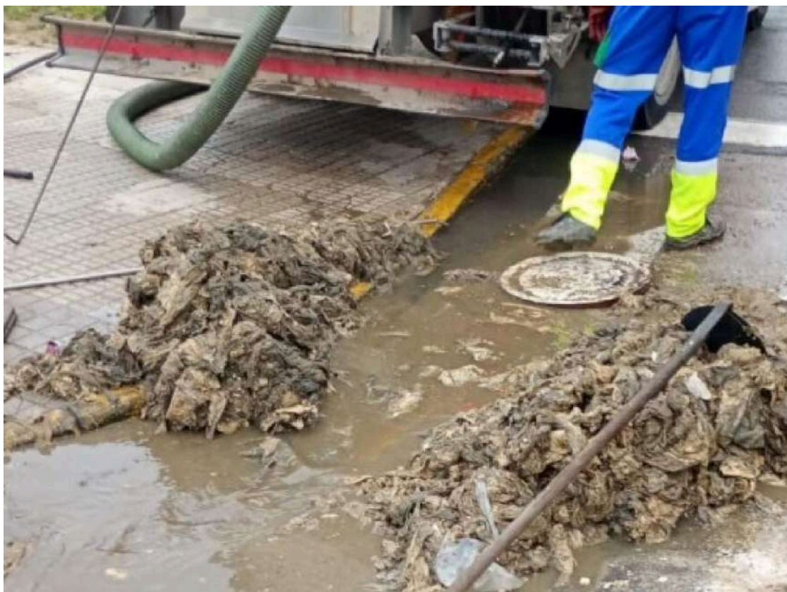
Nuevos trabajos de desatascos se están ejecutando en distintos puntos del municipio ante los problemas originados por el vertido de toallitas húmedas en el sistema de alcantarillado.
