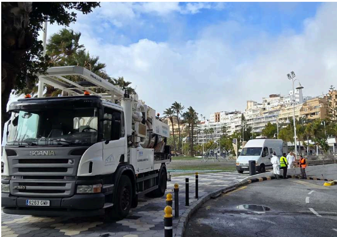
Limpieza de imbornales (MANCOMUNIDAD)
